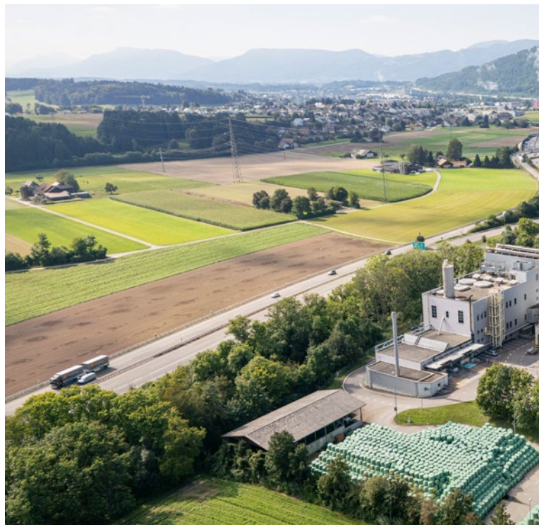
Der gleichzeitige Ausfall mehrerer KVA wäre ein regionales als auch nationales Problem. Im Bild die erzo KVA, die ersetzt werden soll.
